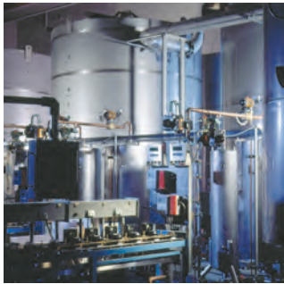
Prüfstand- und Innovationszentrum Test stand and innovation center
